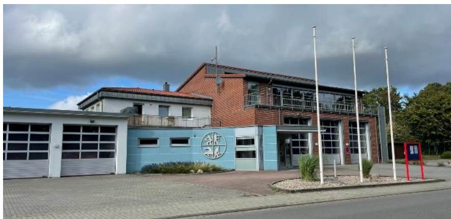
Abbildung 24: Freiwillige Feuerwehr Schacht-Audorf (CIMA 2025)
